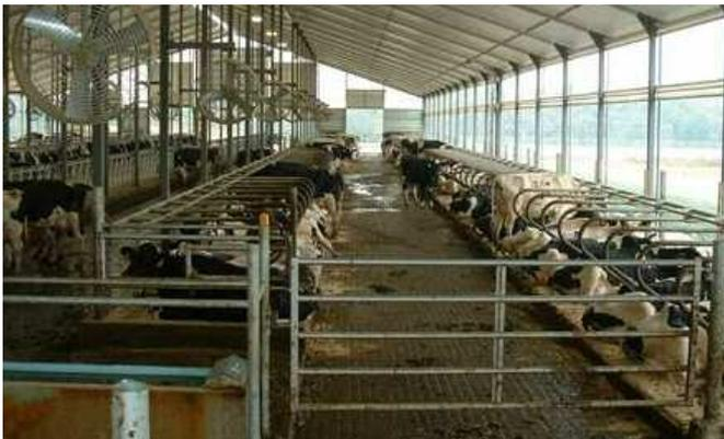
Dependiendo del caudal de aire del ventilador, se determinará la superficie ventilada y esto marcará a qué distancia se debe colocar un ventilador de otro. Los de 120 cm de diámetro se deben colocar a 12 metros y orientados hacia la vaca en un ángulo aproximado de un 15-25 %. Como norma general el ventilador siempre debe apuntar justo debajo del siguiente ventilador.
